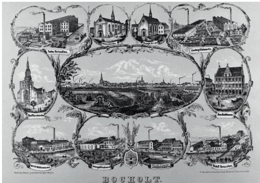
Fabrik-und Kirchengebäude in Bocholt, 1864
